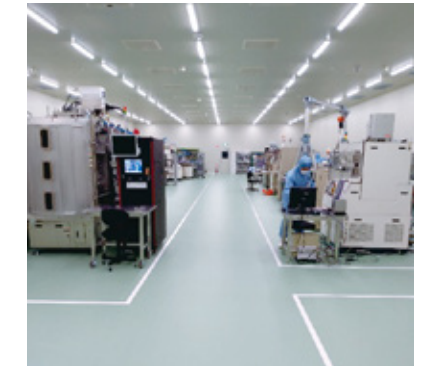
2020年3月より稼働した新研究開発棟（内部クリーンルーム）
